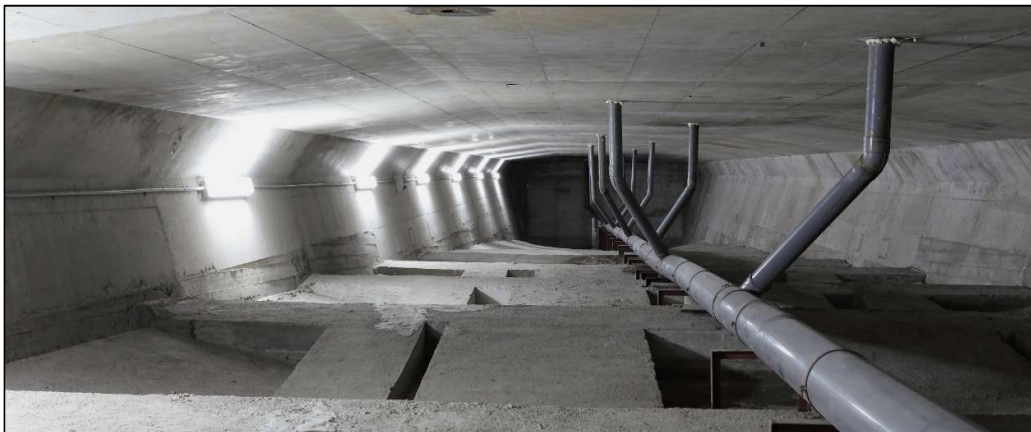
Interior del cajón del viaducto nuevo.
