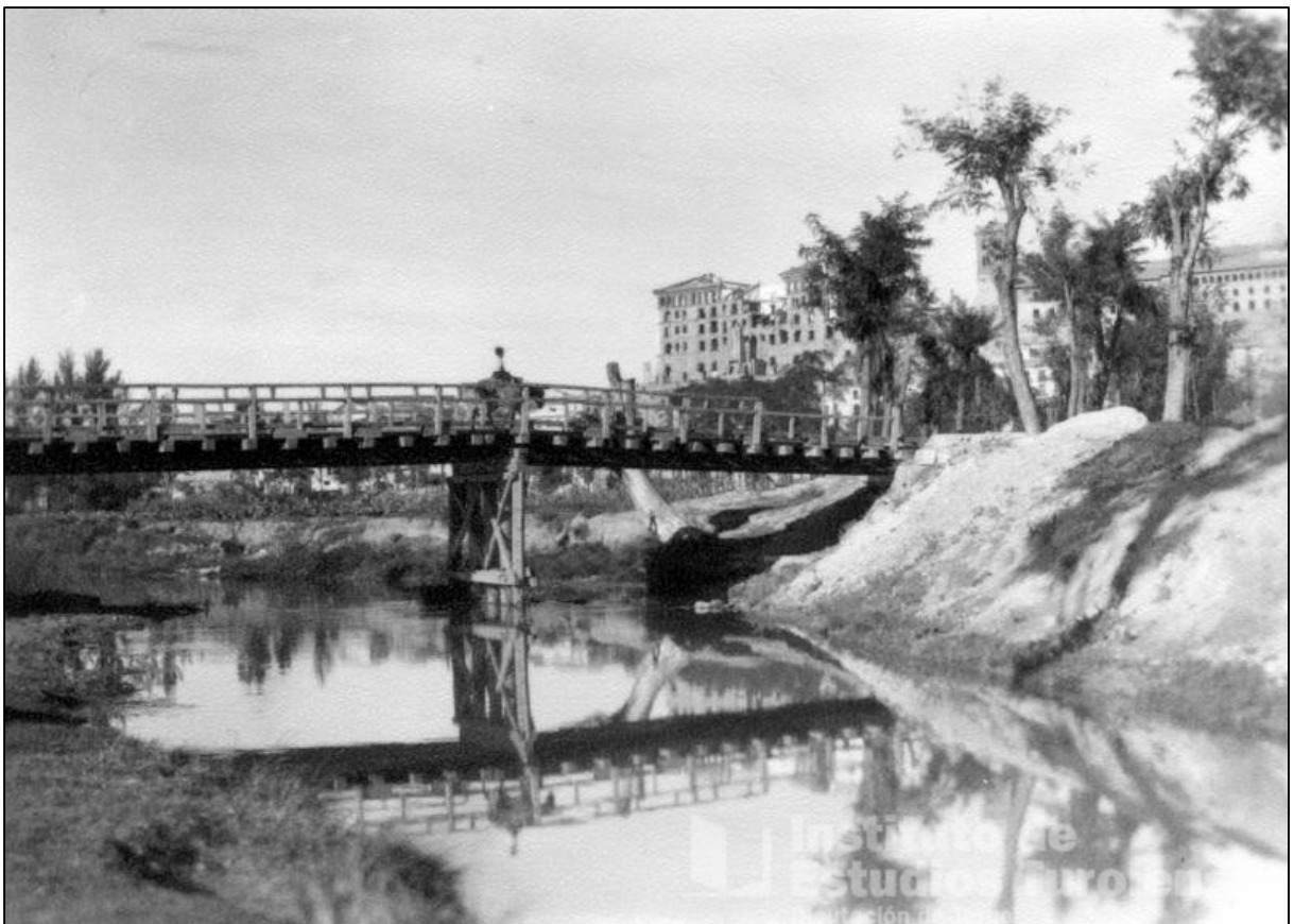
Puente de doña Elvira, reconstruido con pilar de madera.
