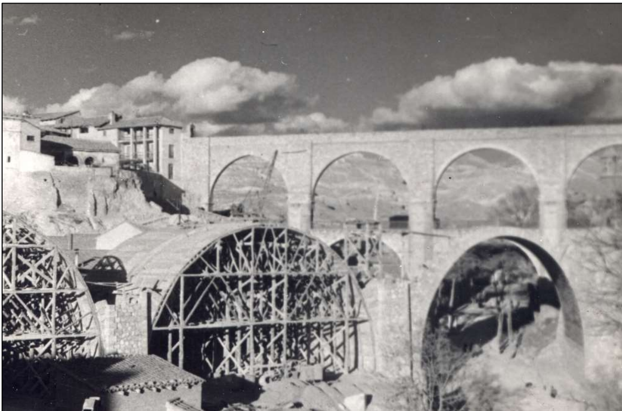
Puente Nuevo, en construcción.
