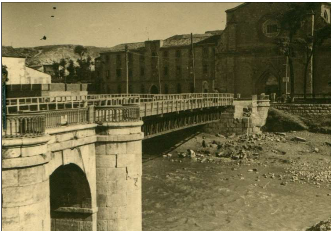
Solución provisional para el puente sobre el Turia. Carretera de Teruel a Tarancón. Fue el paso obligado hasta diciembre de 1954.
