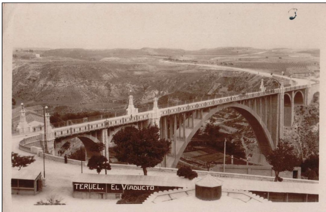
Imagen del viaducto de Teruel y de la variante de carretera que era el objeto del proyecto. La fotografía fue tomada probablemente en 1929.
