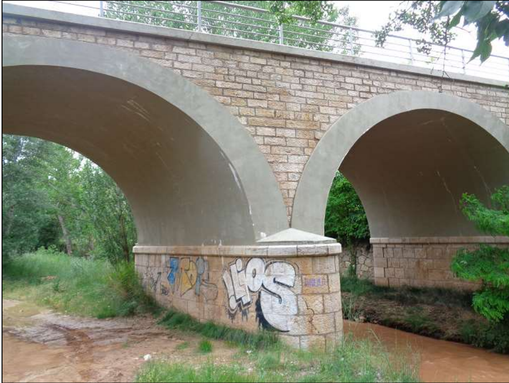
Puente del ferrocarril sobre el río Alfambra.
