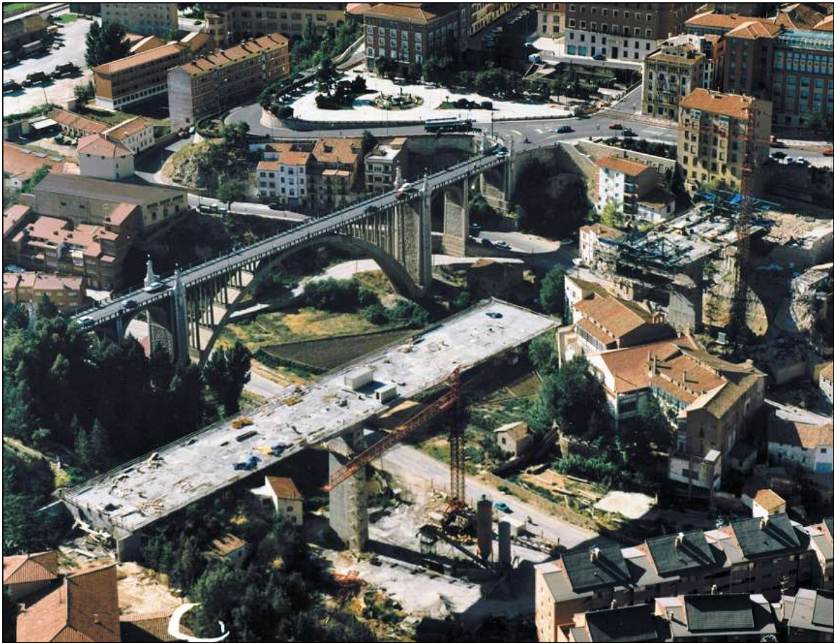
Viaducto Nuevo, en construcción.
