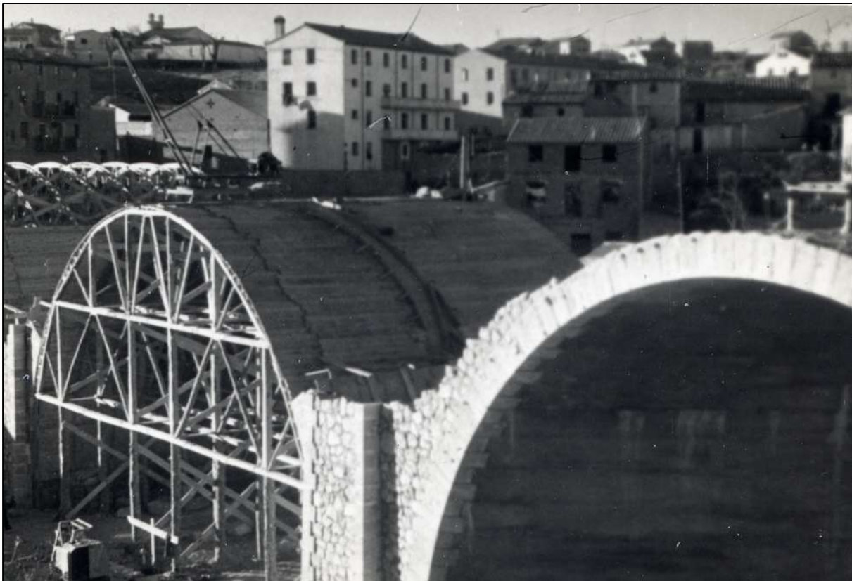
Puente Nuevo en construcción.
